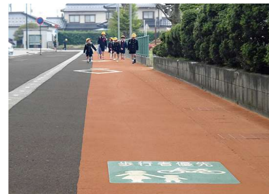
遮熱性薄層舗装
