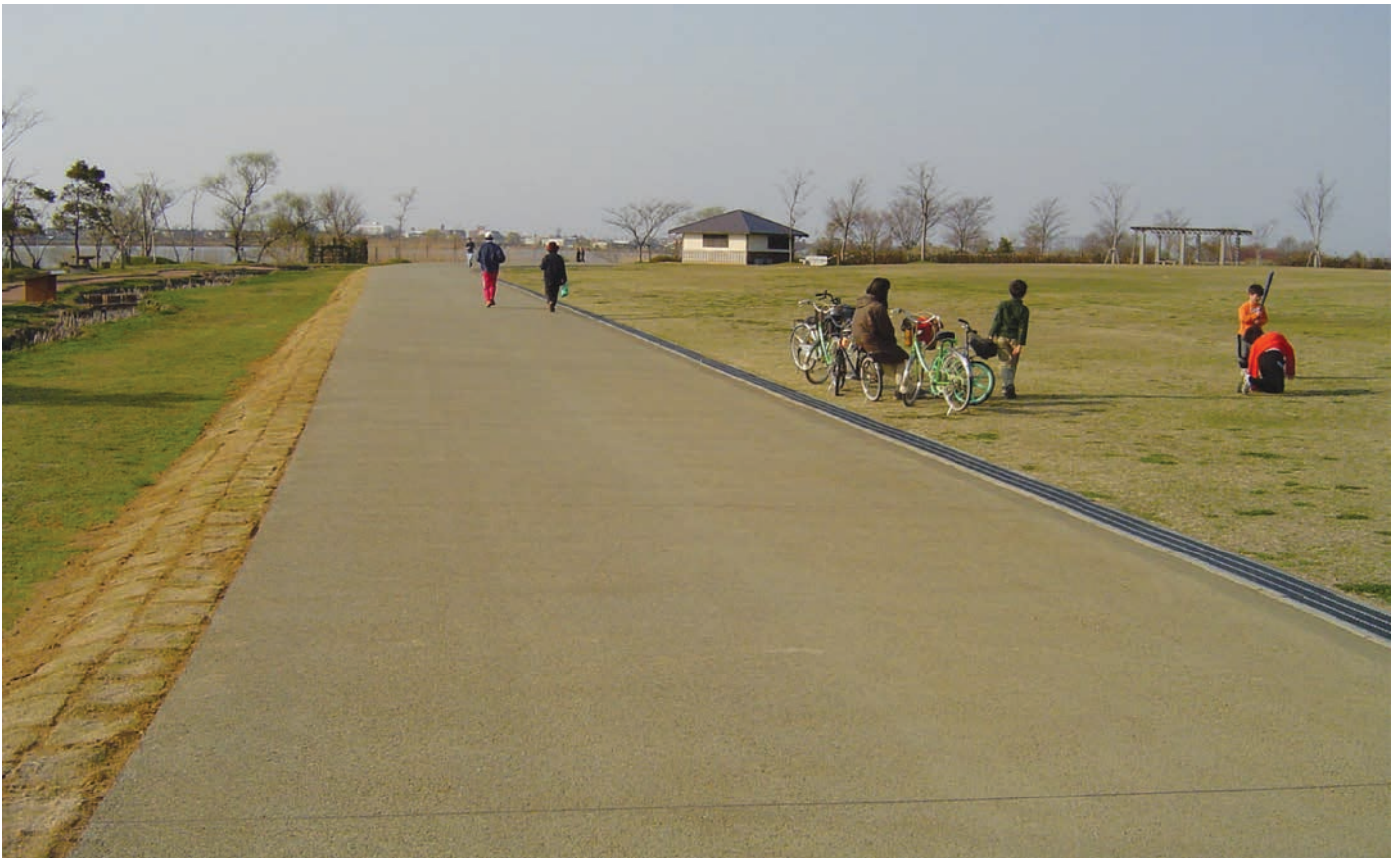
K-ブランド (C)セメント固化 (透水性&保水性舗装)
